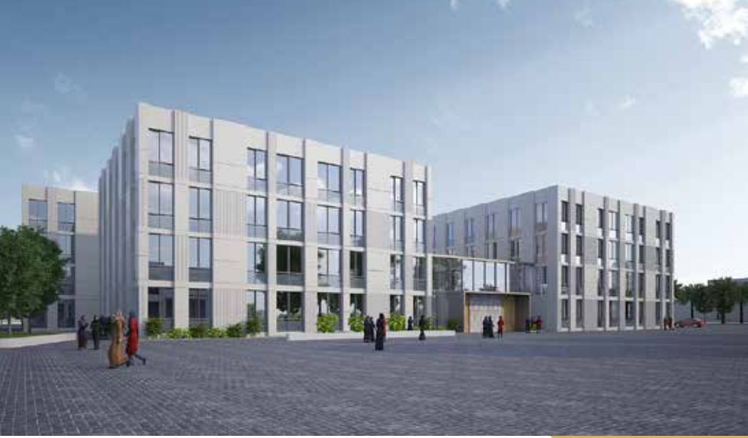
GIRLS' DORMITORY - SOHAR سكن الطالبات - صحر
